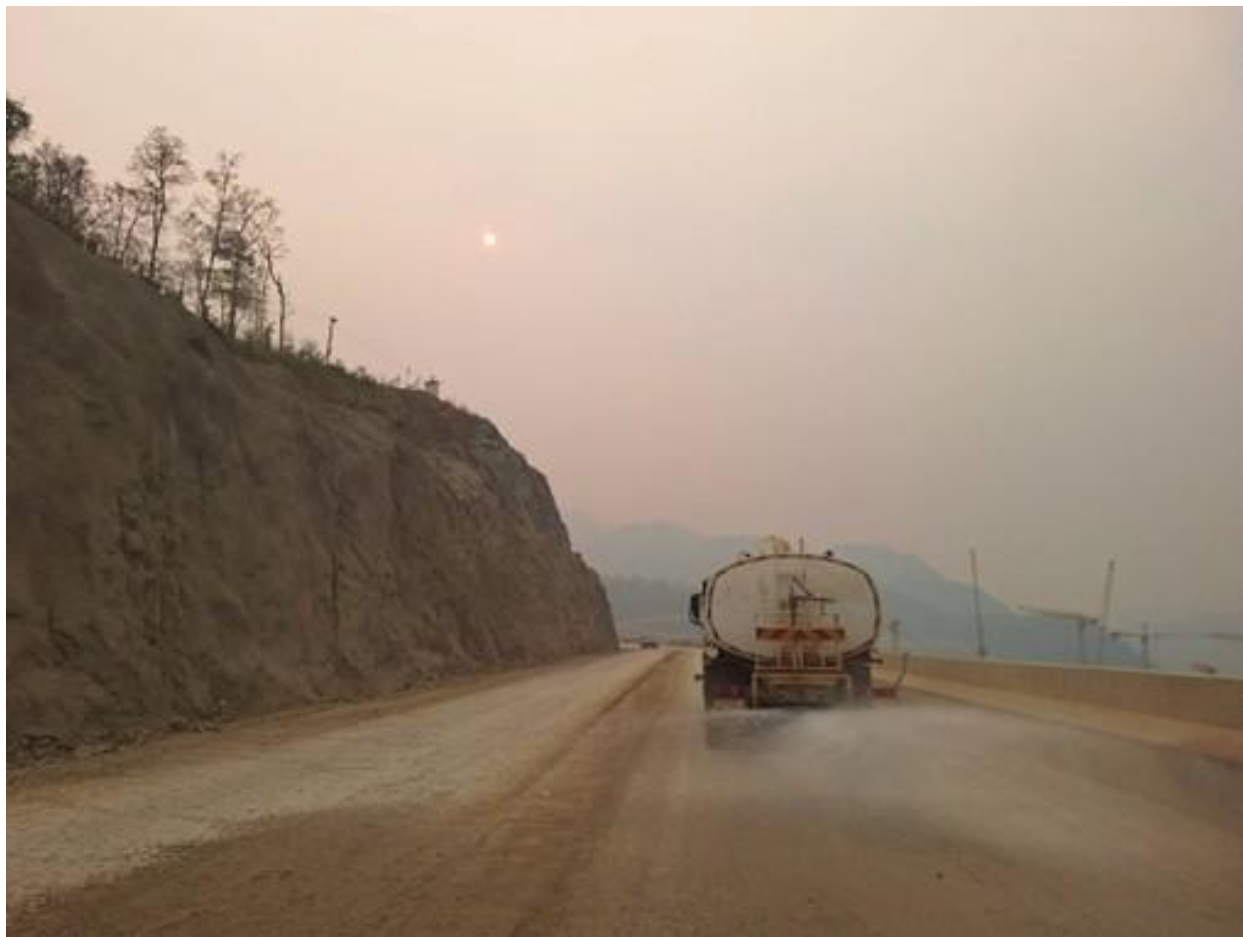
โครงการใช้น้ำหมุนเวียนจาก Batching Plant
